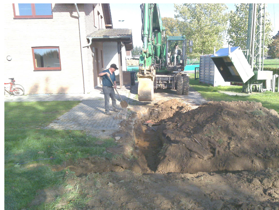
Herbert Hellwig und Mani Zimmermann (im Bagger) bei Zuleitungsarbeiten.
